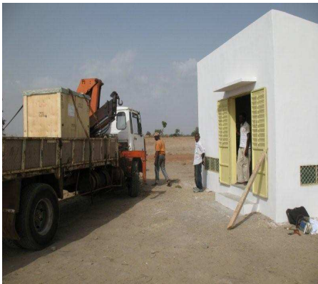
Photo 2 – Arrivée du pilote au forage
